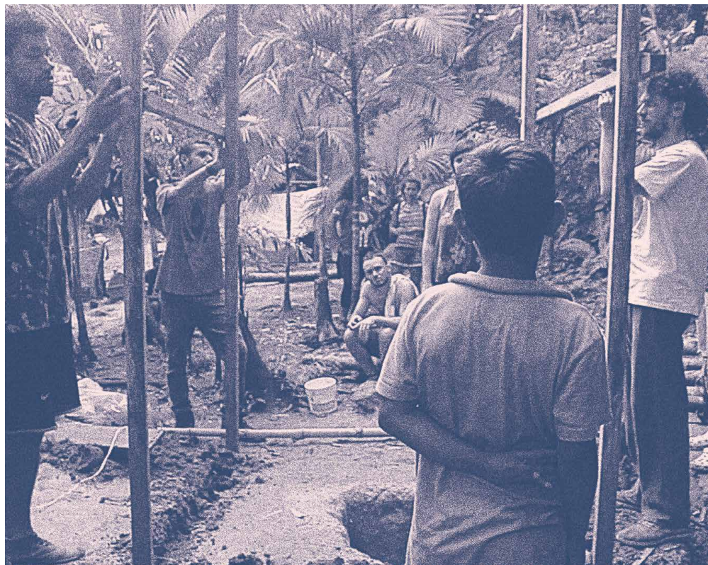
CONSTRUÇÃO DO BANHEIRO A SECO JUNTO À COMUNIDADE GUARANI, EM SÃO VICENTE
